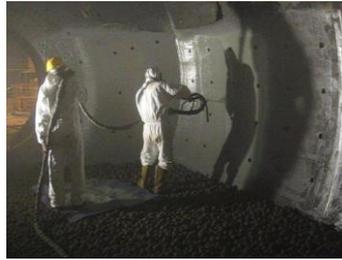
Aplicado a cualquier espesor en una sola capa y curado en minutos, brinda una solución muy rápida para proyectos de mantenimiento industrial que requieren excelente resistencia a la abrasión, resistencia al impacto, protección permanente contra la corrosión del sustrato y una rápida puesta en marcha.
