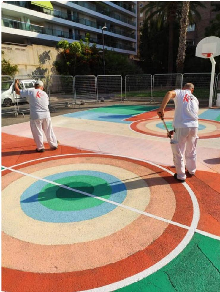
Proyecto singular en pavimentos deportivos, aplicación de COLODUR ECO MATE, poliuretano al agua bi-componente alifático acabado en mate, Libre de VOC, para la protección de zonas deportivas y zonas de mucho tráfico, gran resistencia al desgaste y a los rayos UV.
