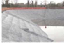
Polyurea Rayston puede ser recubierta con poliuretano alifático para proporcionar protección UV al cambio de color.
