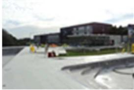
**Polyurea Rayston es un sistema a base de poliurea pura**, de dos componentes de extra rápido curado para la aplicación de membranas elásticas, con puenteo de fisuras. Sólo se aplica por proyección mecánica en caliente. El producto puede combinarse con diferentes geotextiles para obtener "liners" sin juntas de aplicación en continuo.
